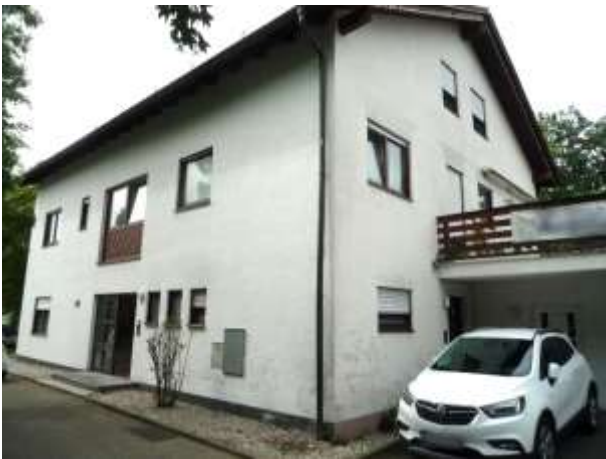
Büro-/Wohnhaus von Norden
