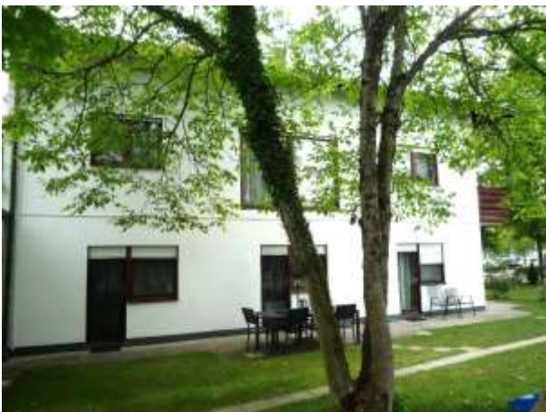
Büro-/Wohnhaus von Südwesten
