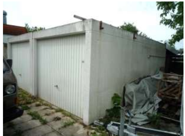
Garagen von Norden
