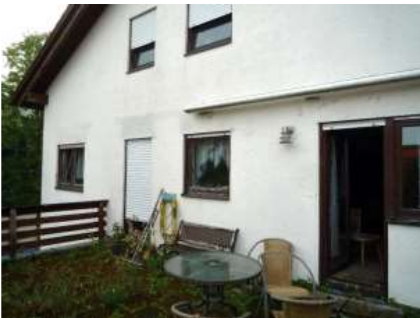
Dachterrasse OG, Ansicht von Westen
