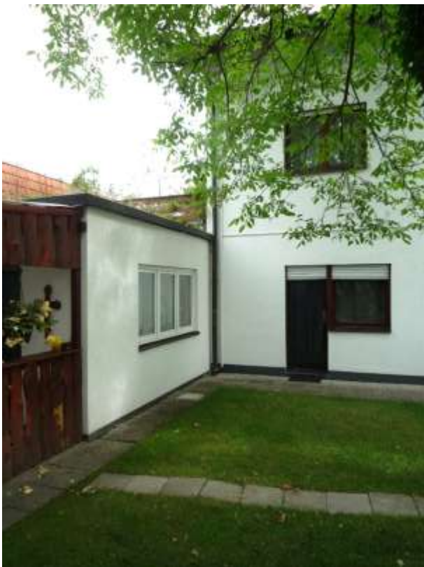
Büro-/Wohnhaus, Anbau von Süden
