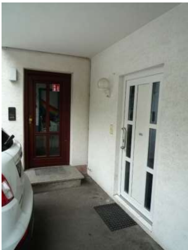
Garage, Zugang Vorraum Heizung
