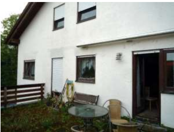
Dachterrasse OG, Ansicht von Westen
