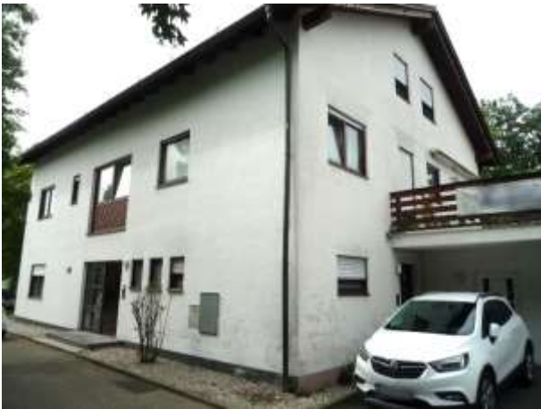
Büro-/Wohnhaus von Norden
