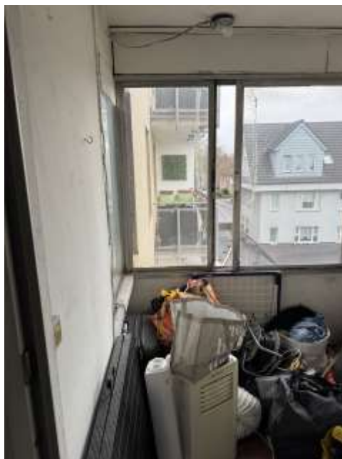
Bild 20: Innenansicht SE Nr. 6 geschlossene Loggia
