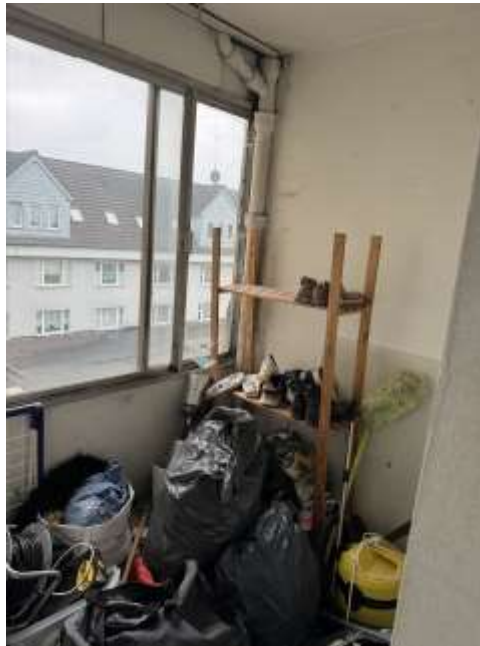
Bild 19: Innenansicht SE Nr. 6 geschlossene Loggia
