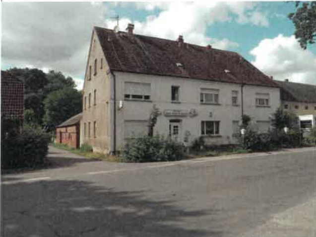
Abbildung: Ehemaliger Gasthof, Ansicht von der Dorfstraße (von der Südostseite)
