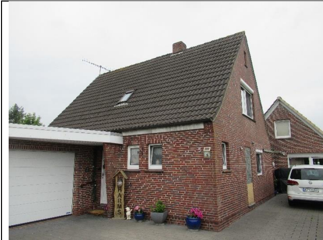
Ansicht Wohnhaus von Nordosten
