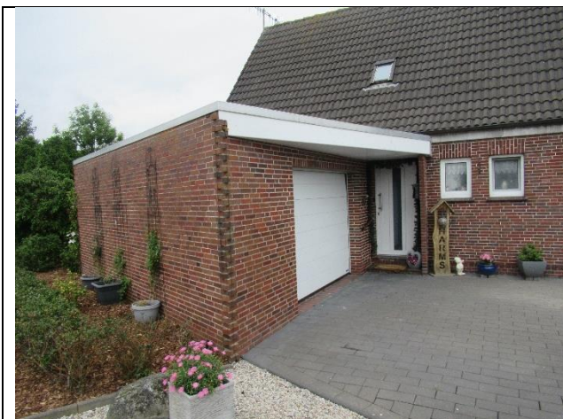
Ansicht Garage von Nordosten
