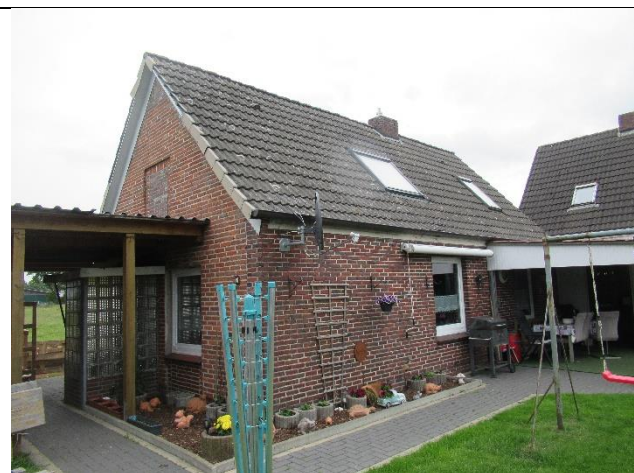
Ansicht Nebengebäude von Südwesten
