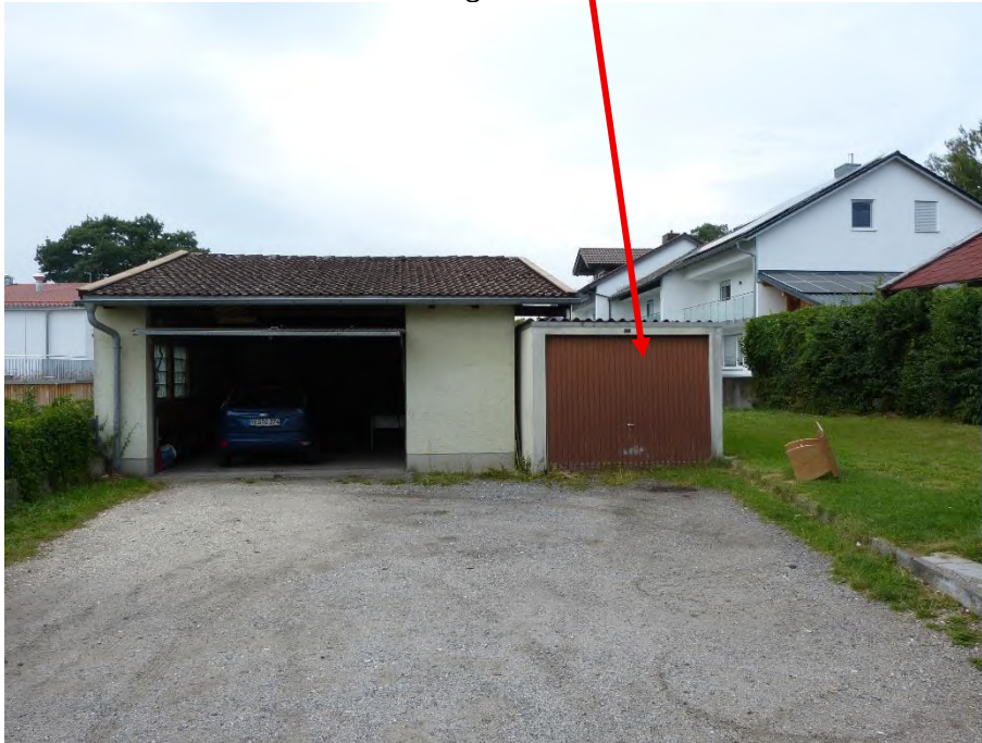
Garagengebäude, Ansicht von Osten
