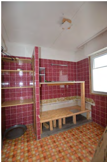
Erdgeschoss – ehemaliges Bad
