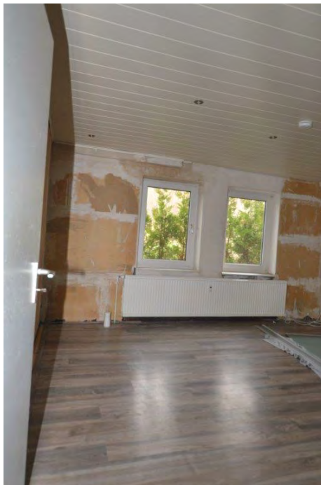
Unter-/ Kellergeschoss – Kinderzimmer
