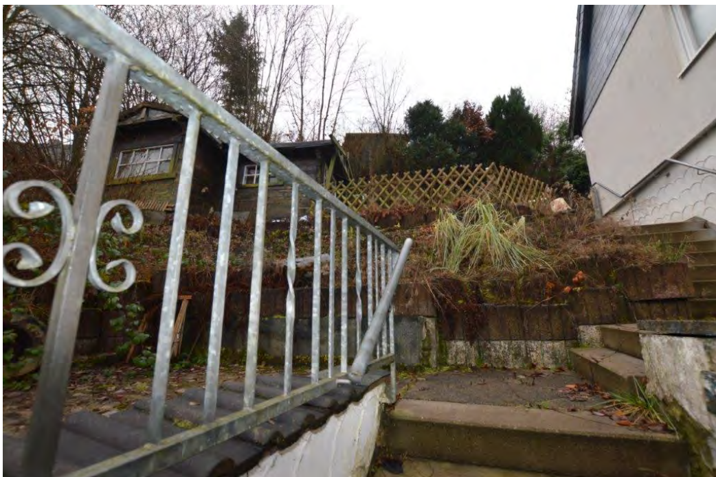
Treppen zum Hauseingang
