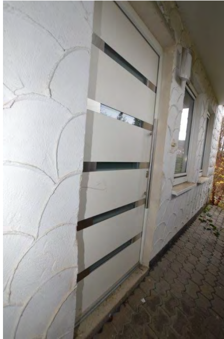
Vorderseite – Eingang zum Unter-/ Kellergeschoss
