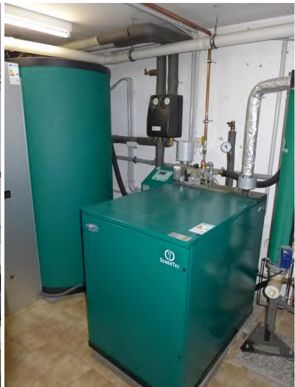
10 b Blockheizkraftwerk
