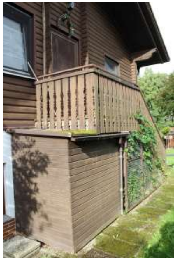
Bild 5: Ansicht Nordostseite Feriendorf „Hohen Bogen“ 53 von Osten
