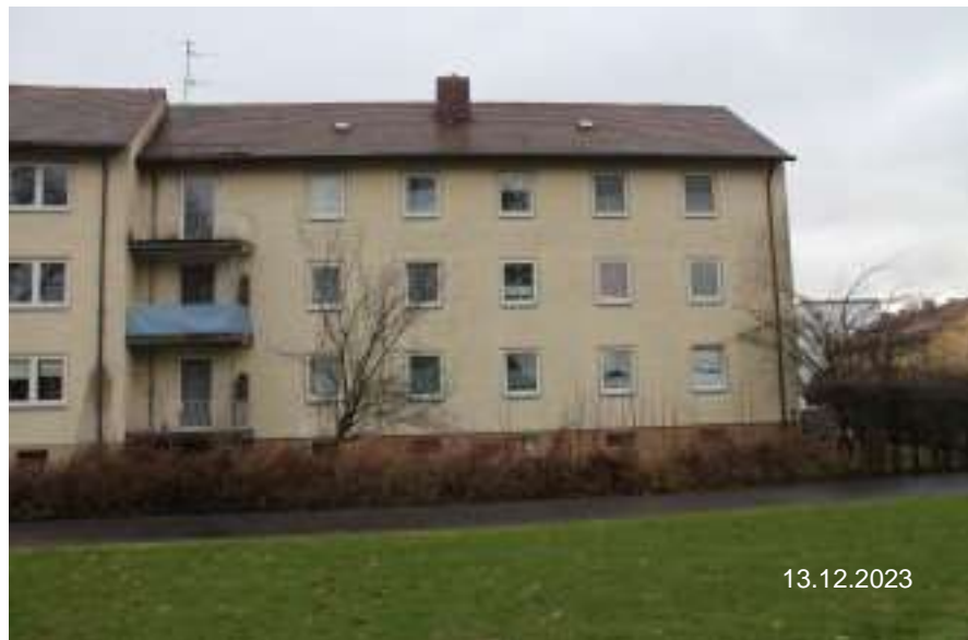
Bild 8: Fl.Nr. 522 Ansicht Anwesen Alfred-Peter-Platz 2 von Westen
