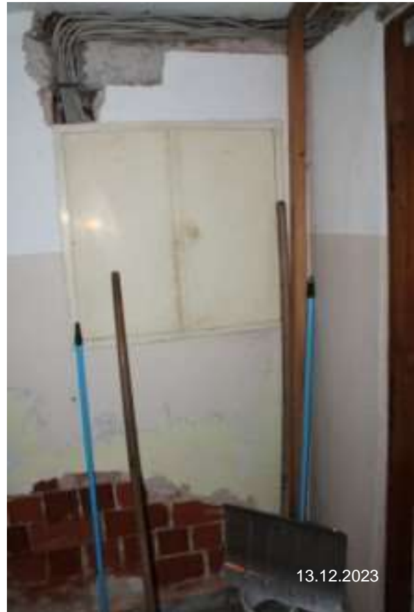
Bild 7: Fl.Nr. 522 Ansicht TH EG im Anwesen Jettinger- str. 1
