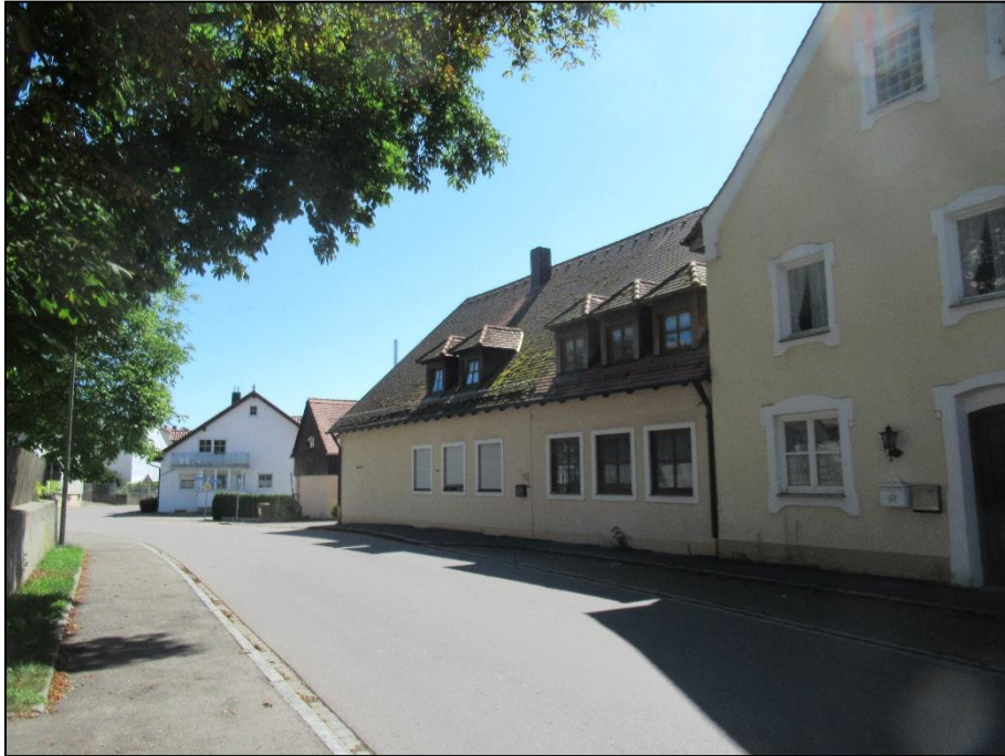
Haus Nr. 2a – Ansicht - Norden
