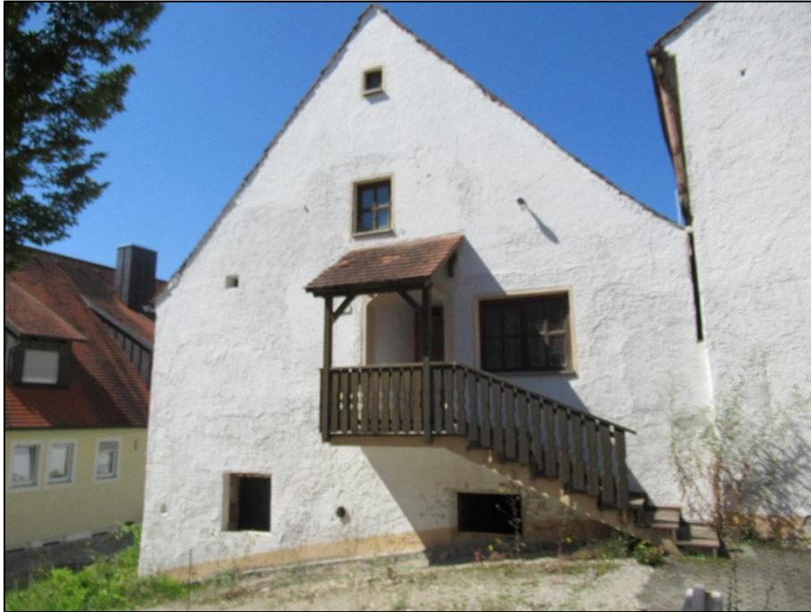
Haus Nr. 3 - Ansicht - Osten
