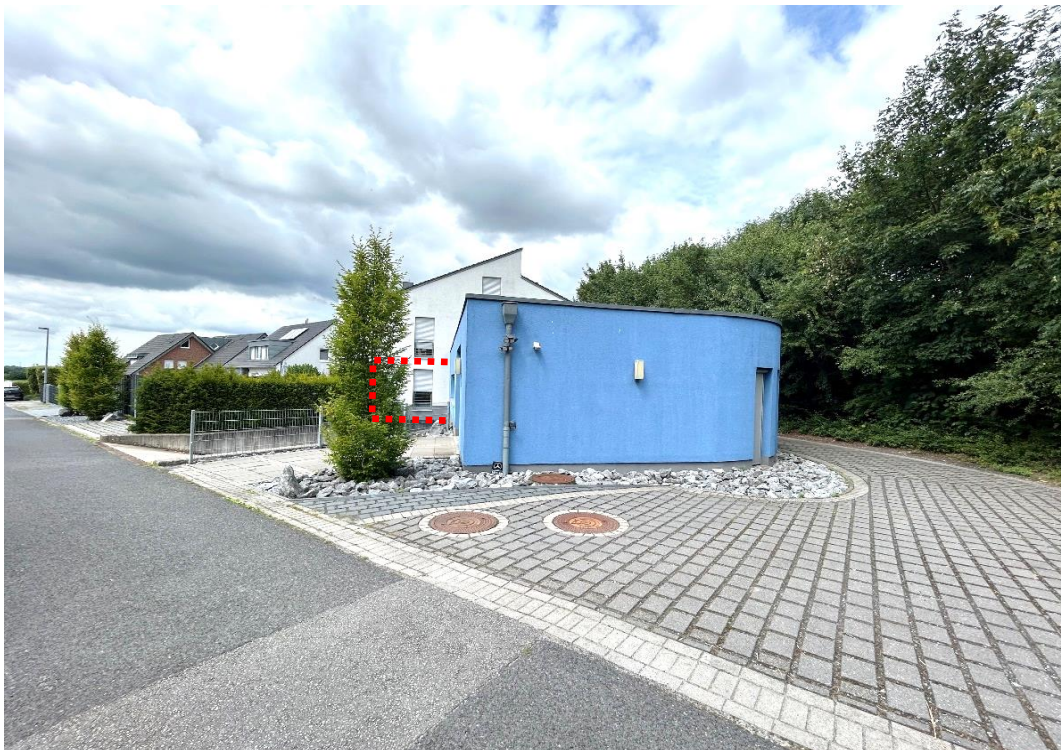
Ansicht von Südosten
