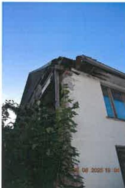
schadhafter Dachbereich
