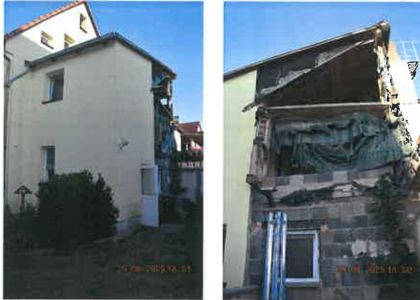
rückwärtiger Anbau mit tlw. wiederaufgebauter Erdgeschossenebene
