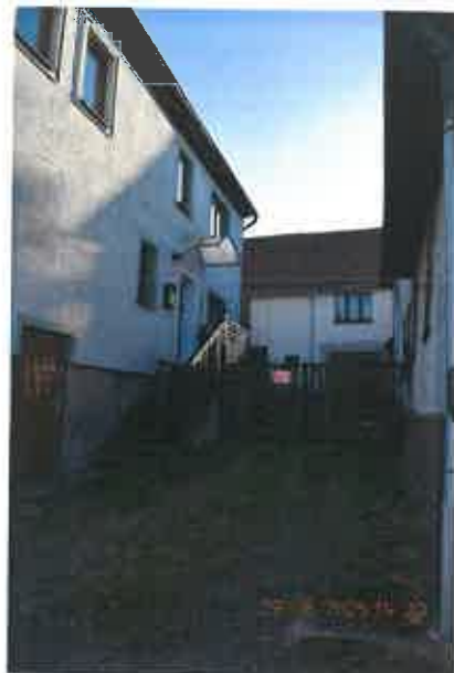
Zufahrt zum rückwärtigen Grundstück
