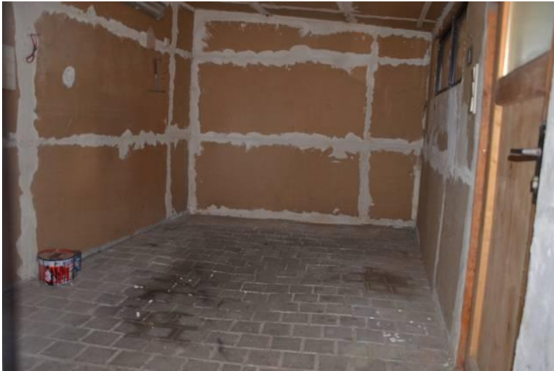
Foto 19 INNENRAUM DES NEBENGEBÄUDES
