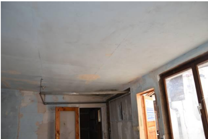
Foto 20 INNENRAUM DES NEBENGEBÄUDES
