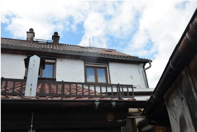
Foto 4 ANSICHT VOM HINTERRAUM
