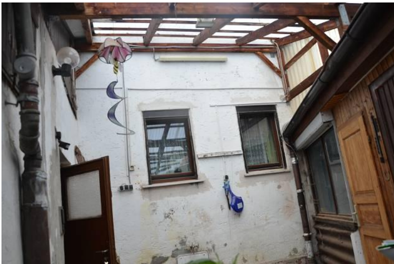
Foto 17 HOFÜBERDACHUNG UND NEBENGEBÄUDE
