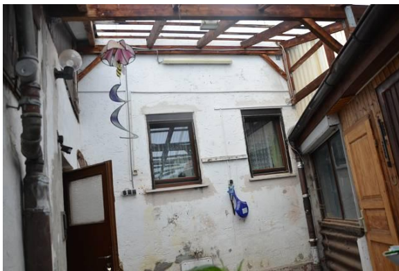
FOTO 4 Garage und Nebengebäude im Hinterraum
