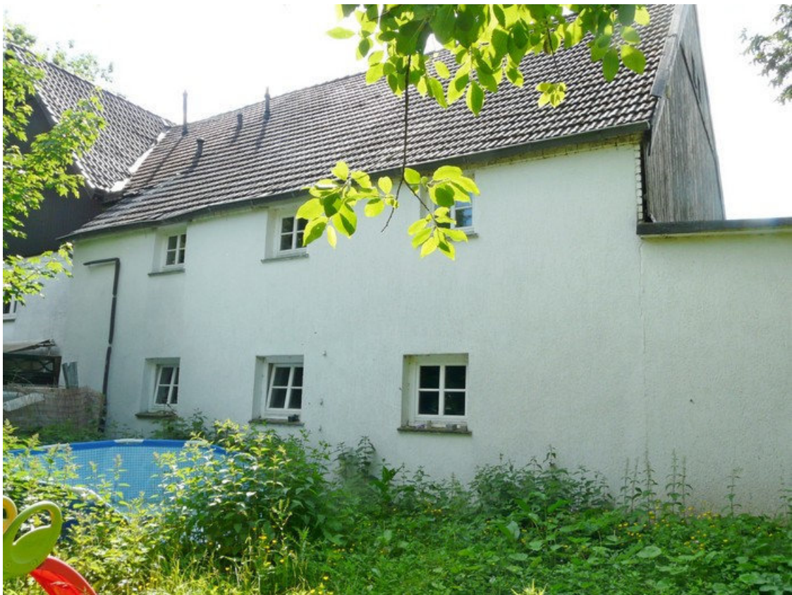
Teilansicht von Nordwesten
