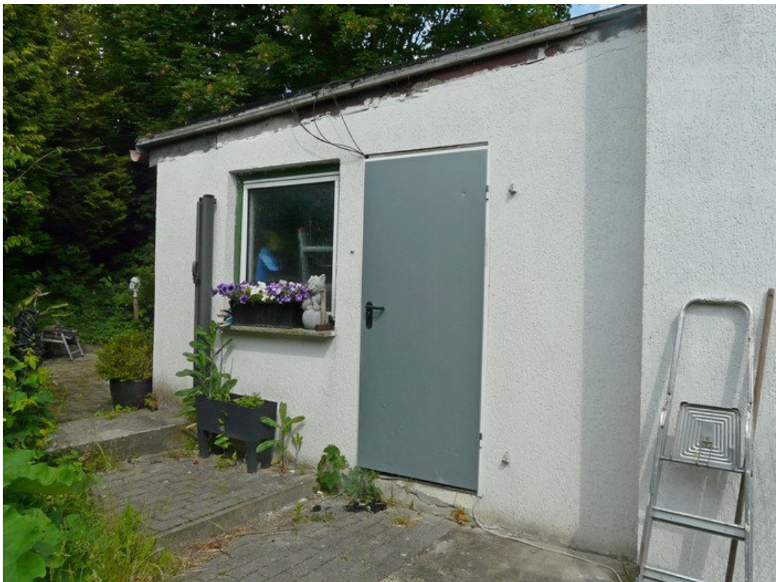
Teilansicht von Südosten
