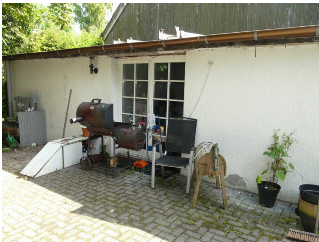
Teilansicht von Südwesten
