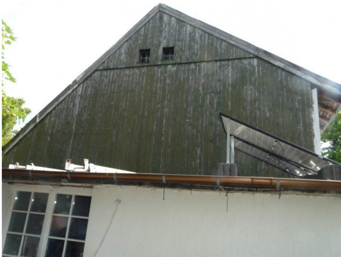
Teilansicht von Südwesten
