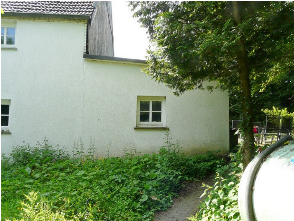
Teilansicht von Nordwesten
