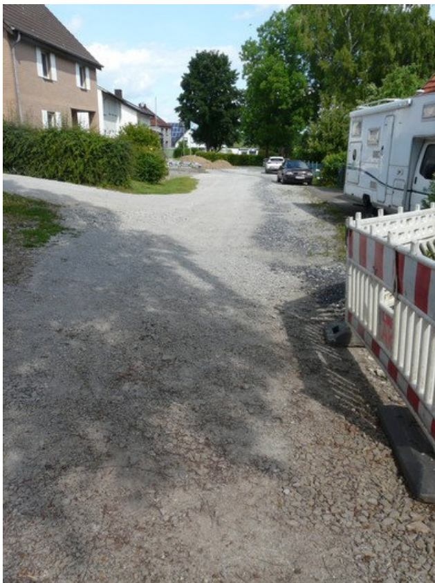
Umgebung in Richtung Nordwesten (Straße Am Born)
