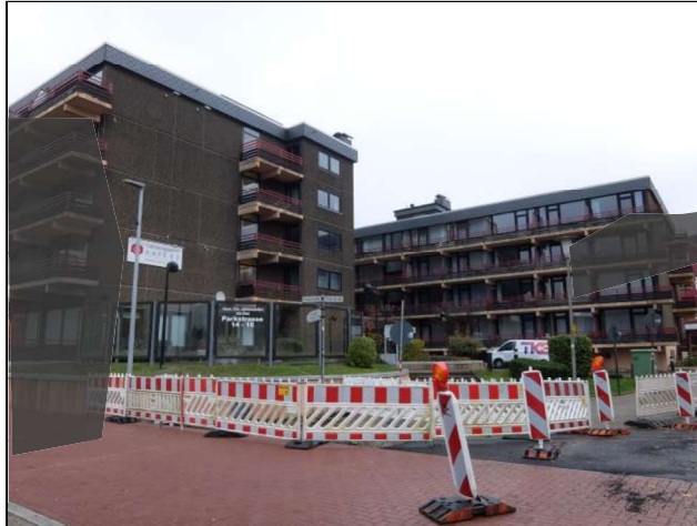
Ansicht von Süd-West
