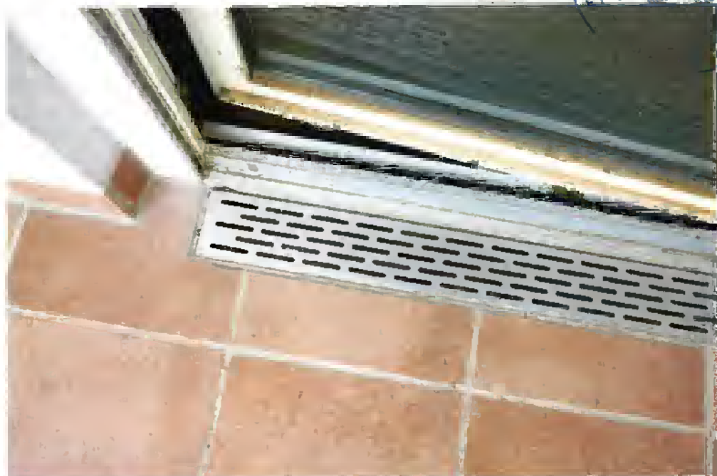
Bild 10: Einlaufrinne verschmutzt
