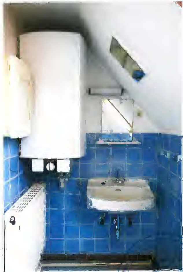
Bild 17: Blick in das Bad DG
