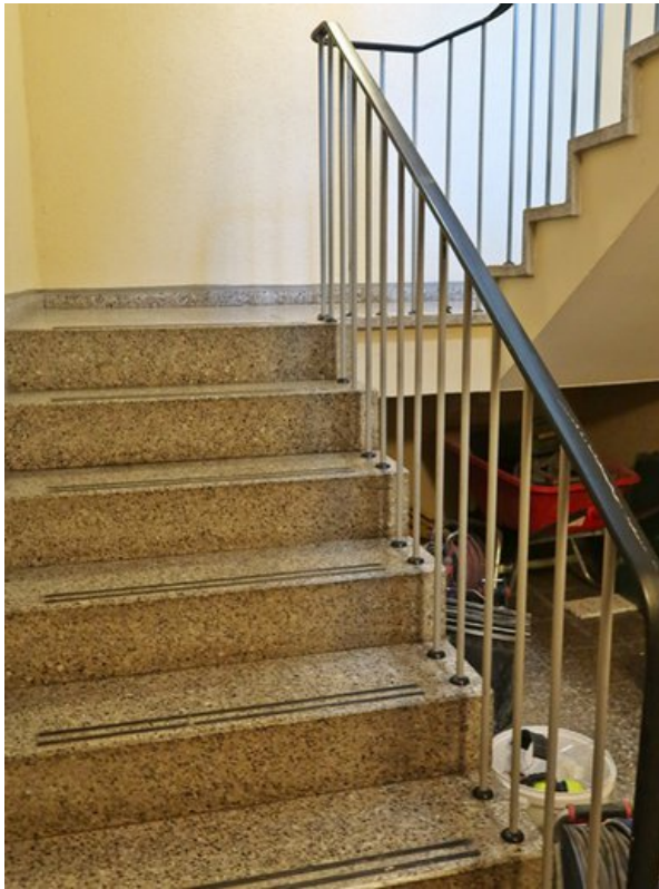
Treppe zum Kellergeschoss
