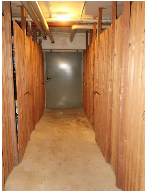
Flur zu den Abstellräumen
