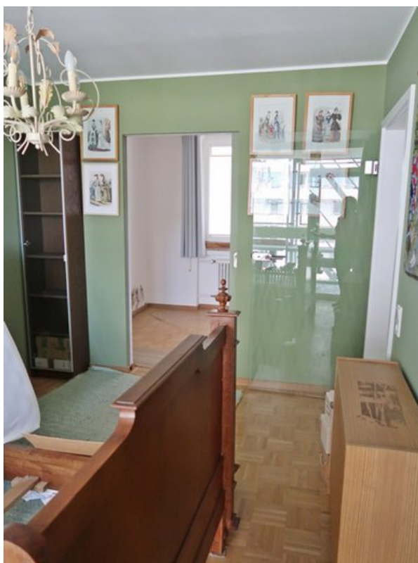
Nachträglich errichtete Trennwand mit Schiebetürenanlage im Schlafraum
