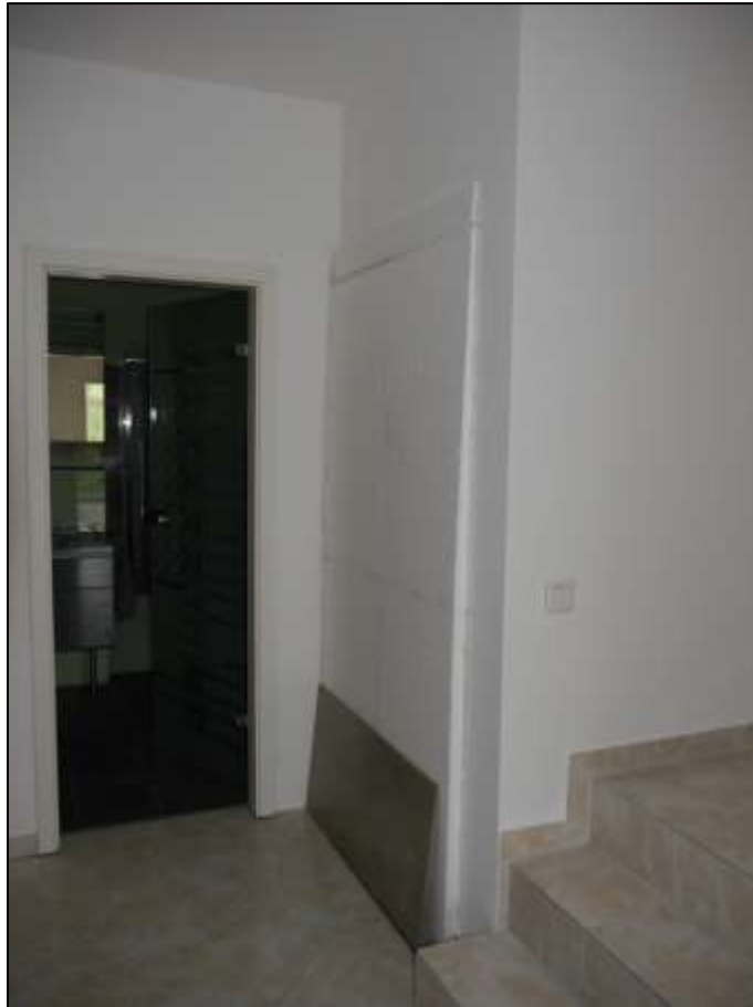
Flur im 3.OG mit anbinden- dem Badezim- mer der oberen Maisonette und provisorisch ab- gesperrter Zu- gang zum Auf- zugsschacht
