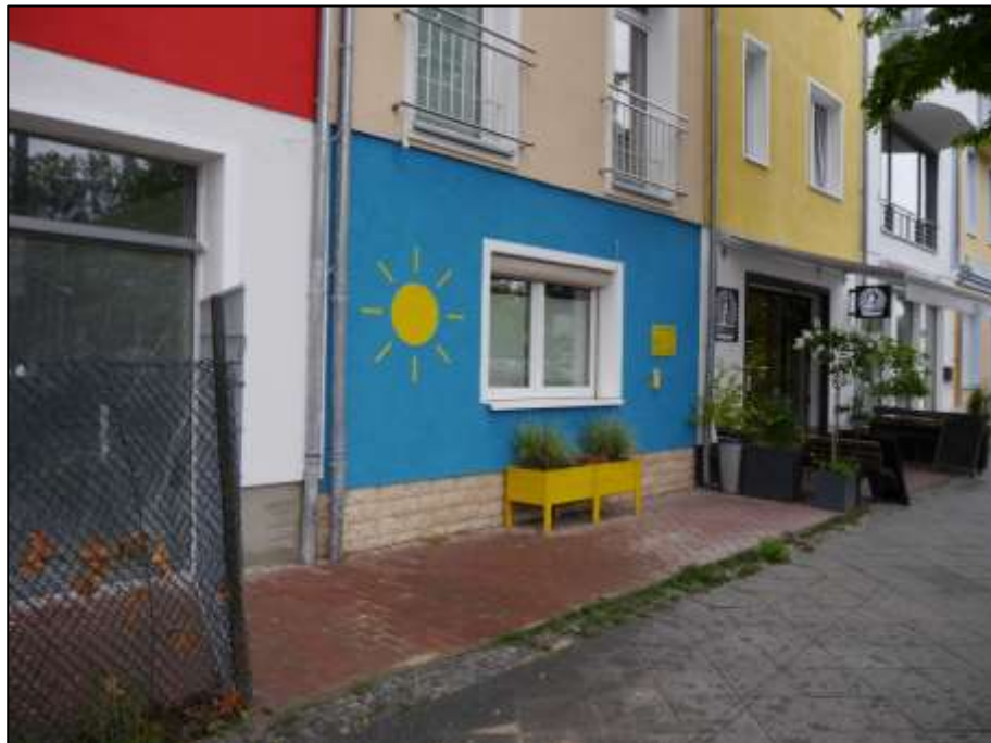
zur Buddestraße orientierte Gebäudefront des auf dem Grundstück Buddestr. 31E, Königsweg 24 aufstehenden Reihenmittelhauses im Bereich des Erdgeschosses
