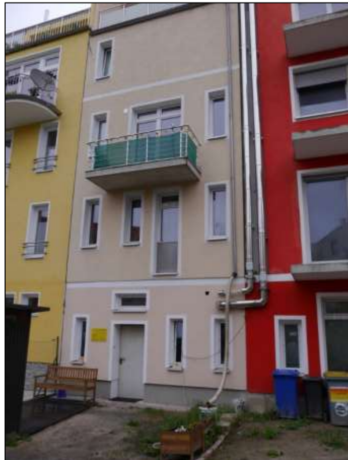
Hauseingangsfrent des auf dem Grundstück Buddestr. 31E, Königsweg 24 belegenen Reihenmittelhauses
