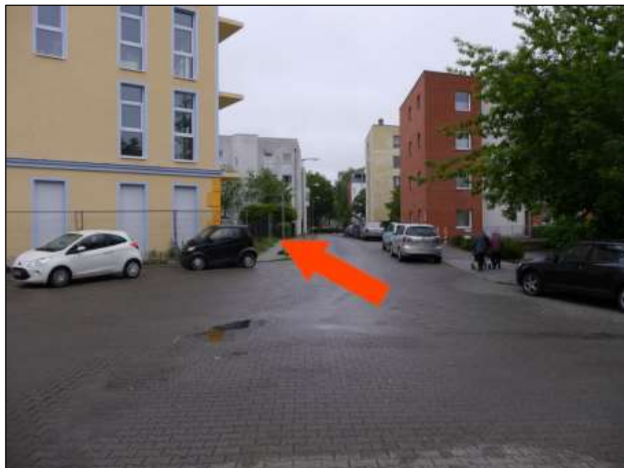
Blick aus dem Wendehammerbereich des Königswegs vor der Buddestraße nach Süd-Westen mit Lage des Grundstücks Buddestr. 31E, Königsweg 24 auf der süd-östlichen Straßenseite (Pfeil)
