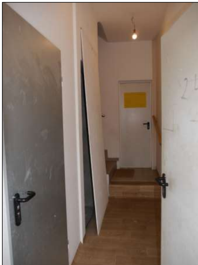
Hauseingangsflur im Erdgeschoss des auf dem Grundstück Buddestr. 31E, Königsweg 24 aufstehenden Reihenmittelhauses
