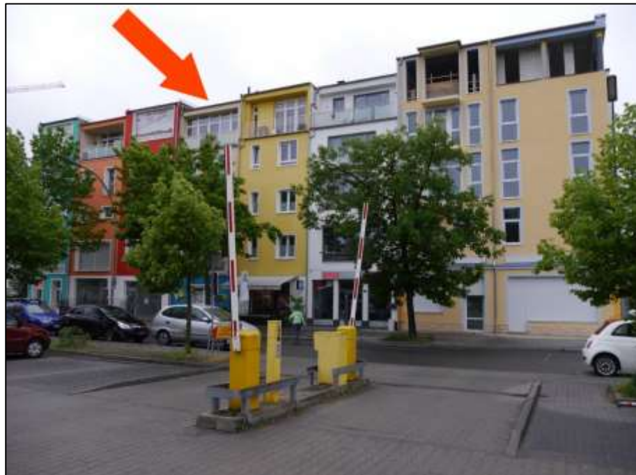
Blick über die Buddestraße nach Süd-Westen mit Lage des Grundstücks Buddestr. 31E, Königsweg 24 auf der süd-westlichen Straßenseite nebst aufstehendem Reihenmittelhaus (Pfeil)
