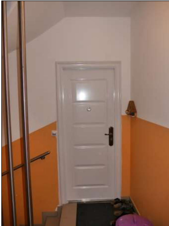
Wohnungseingangstür im 1.OG der unteren Maisonette
