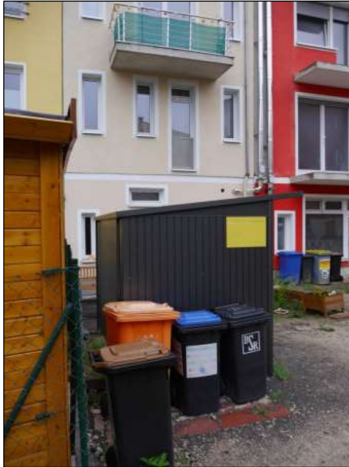
Stahlblechschuppen als Kellerersatzraum auf dem Grundstück Buddestr. 31E, Königsweg 24
