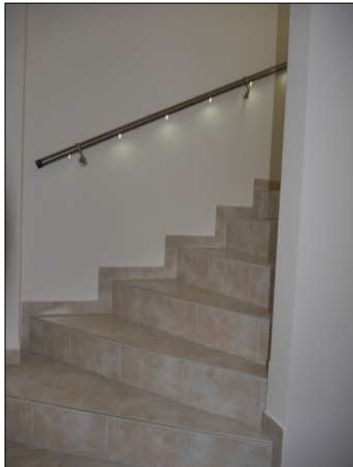
Treppenaufgang innerhalb der oberen Maisonette aus dem 2.OG zum 3.OG
