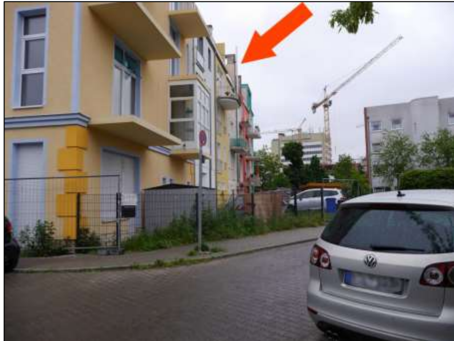
Blick aus dem Wendehammerbereich des Königswegs vor der Buddestraße nach Süd-Westen mit Lage des Grundstücks Buddestr. 31E, Königsweg 24 auf der süd-östlichen Straßenseite nebst aufstehendem Reihenmittelhaus (Pfeil)
