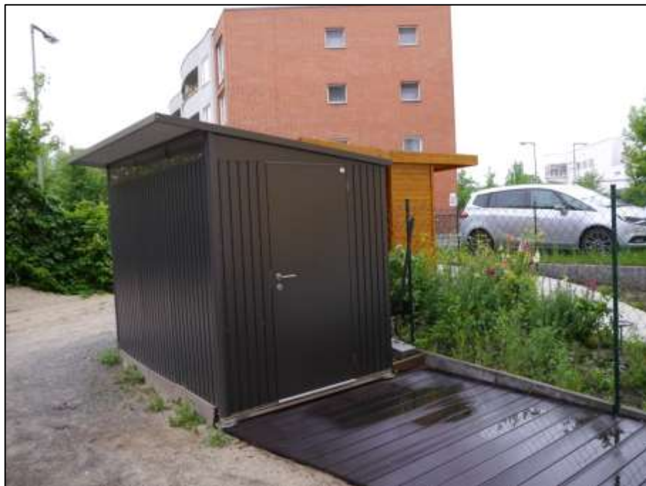
Stahlblechschuppen als Kellerersatzraum auf dem Grundstück Buddestr. 31E, Königsweg 24
