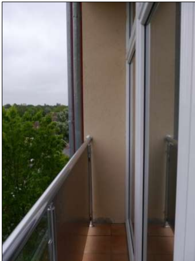
Fenstertüraustritt an der zur Buddestraße orientierten Gebäudefront im 4.OG
