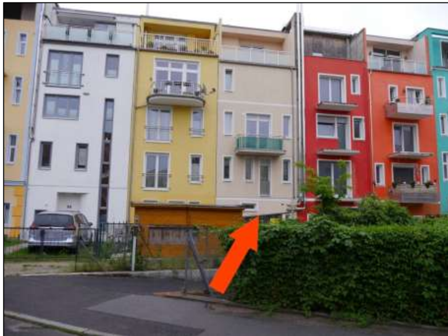
Blick über den Königsweg nach Osten mit Lage des Grundstücks Buddestr. 31E, Königsweg 24 auf der süd-östlichen Straßenseite nebst aufstehendem Reihenmittelhaus (Pfeil)
