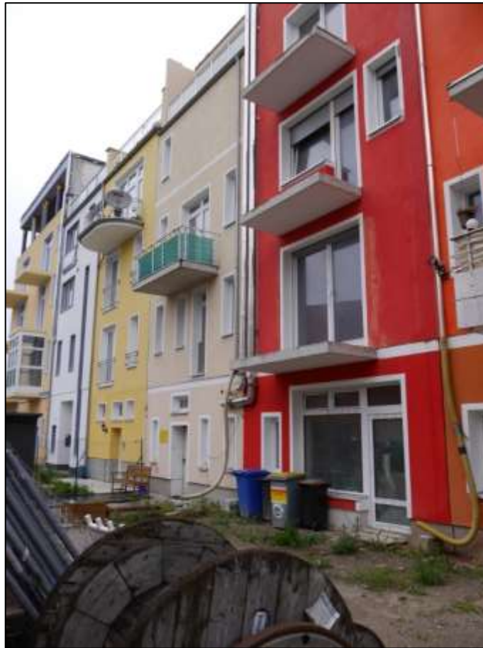
Hauseingangsfront des auf dem Grundstück Buddestr. 31E, Königsweg 24 belegenen Reihenmittelhauses
