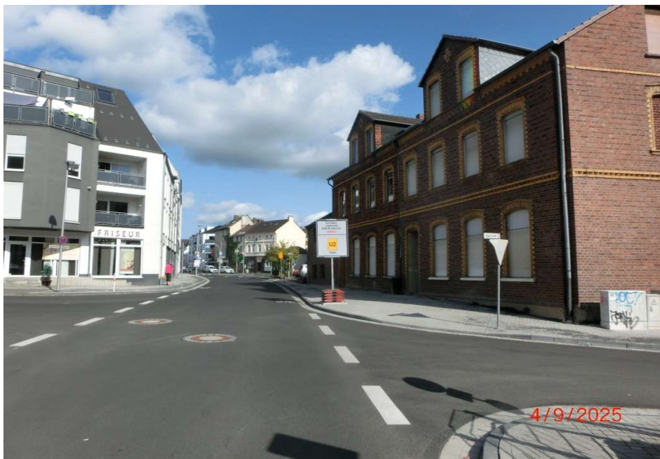
Seitenansicht und Blick zur Luisenstraße
