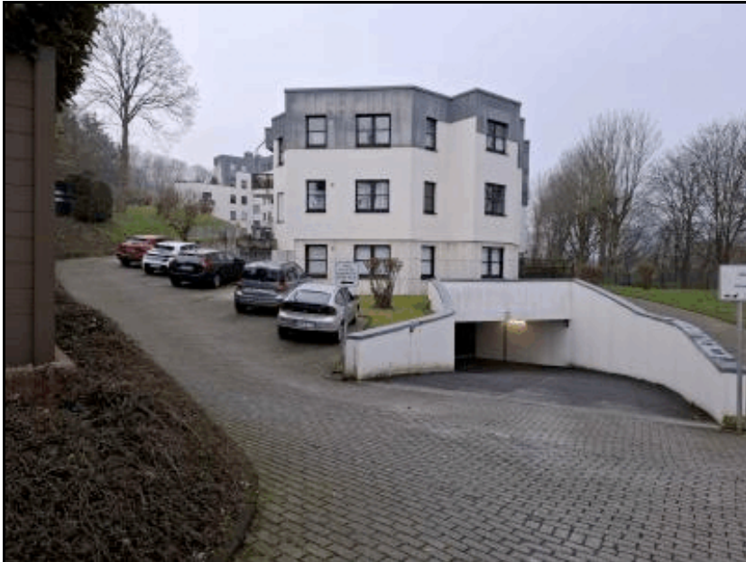
Foto 1: Zufahrt zur Tiefgarage
