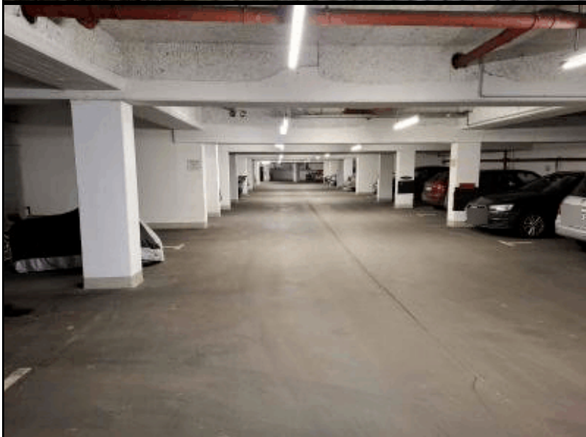
Foto 2: Blick in die Tiefgarage
