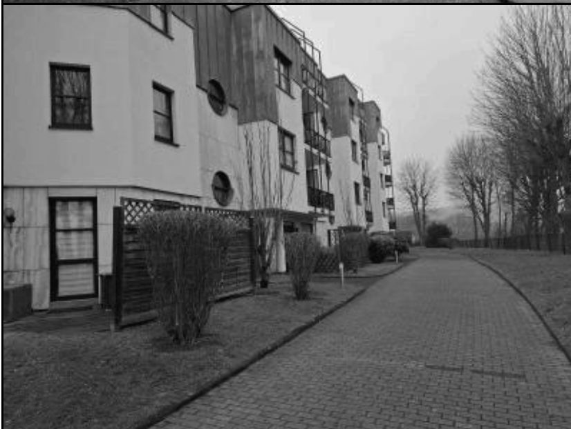
Foto 3: Zugang zur Anlage
