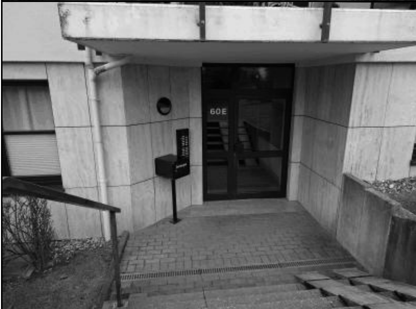
Foto 2 Zugang zum Haus
