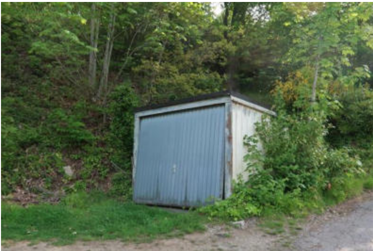
Blechgarage in der Mitte des Privatweges mit deutlichen Korrosionsspuren.
