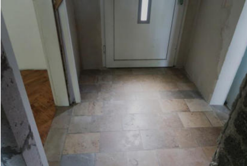
Eingangshalle im Anbau mit Plattenbelag.
