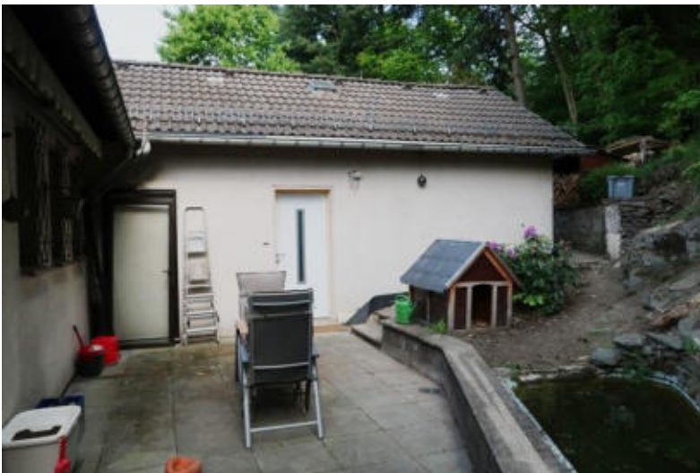
Terrasse im Winkel zwischen Ursprungsgebäude und Anbau
