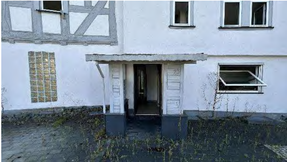
Bild B5 Hauseingang
