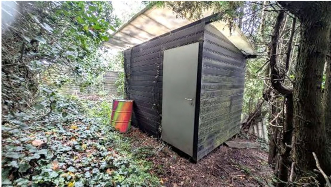
Bild B9 Freifläche hinter Scheune
