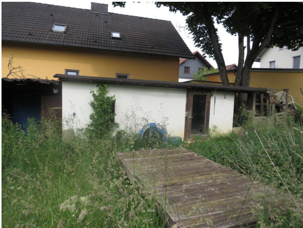
Abbildung: Ansicht von Osten
