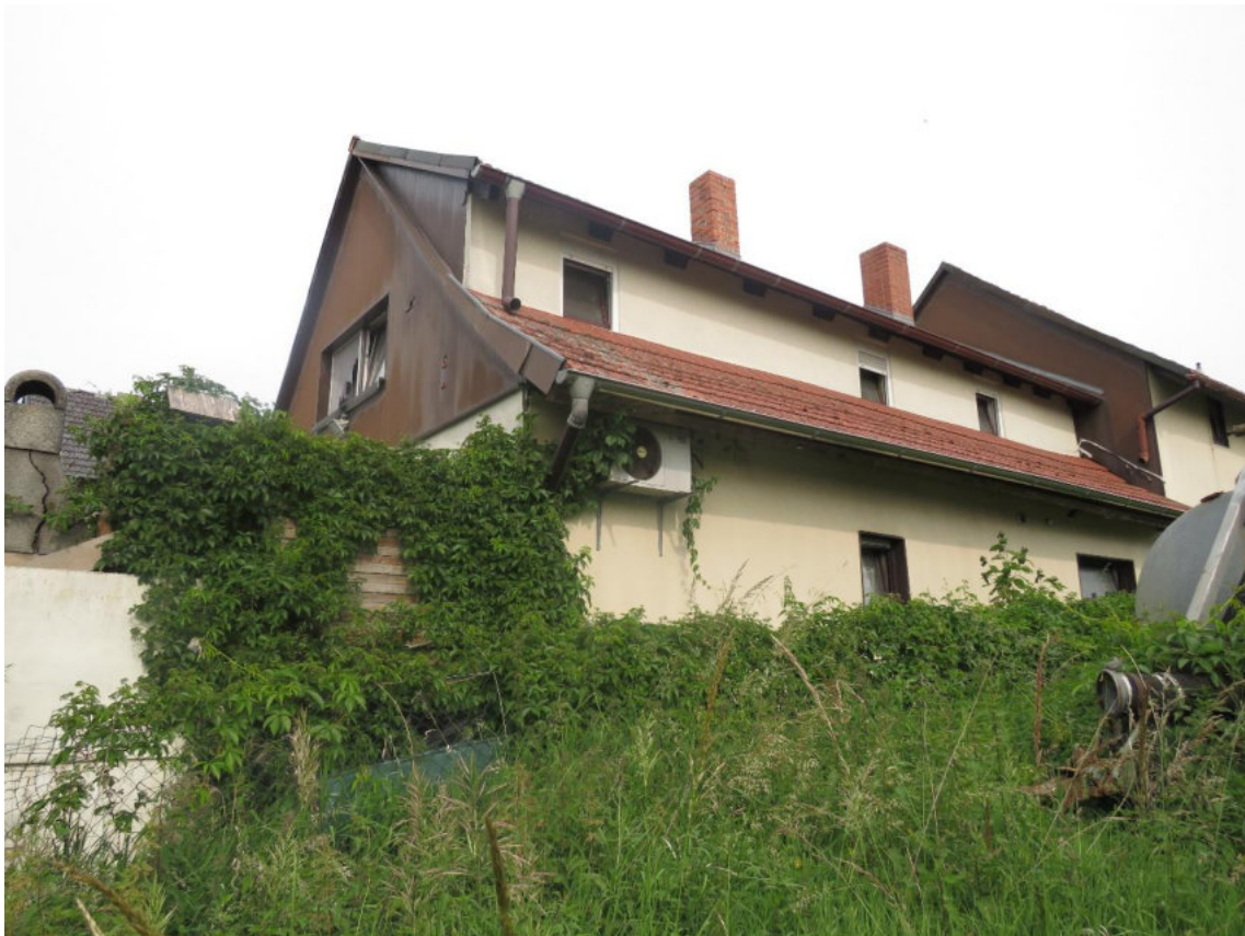
Abbildung: Ansicht von Osten
