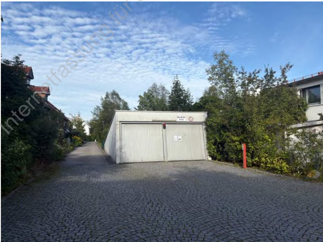
Foto 2: Ein-/ Ausfahrt Tiefgarage
