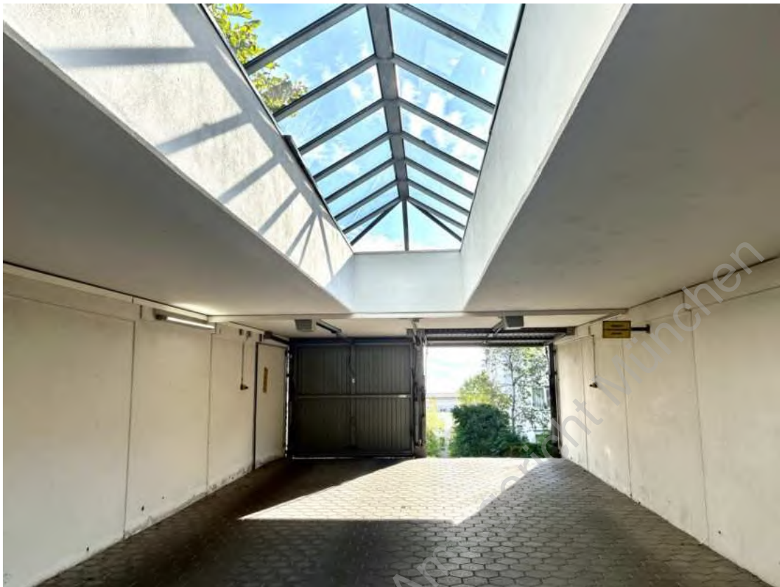
Foto 3: Rampe mit Oberlicht
