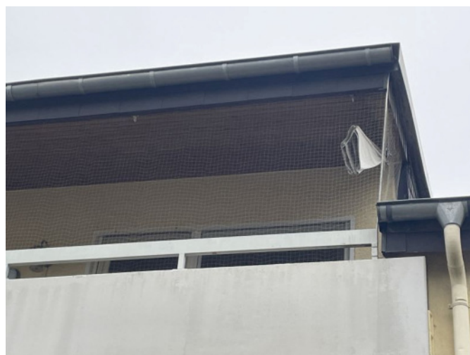
Loggia (mit Netz) der Wohnung Nr. 6 im Dachgeschoss
