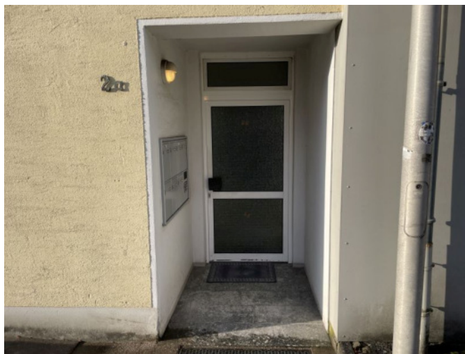
Hauseingang Gerichtstraße 2 a
