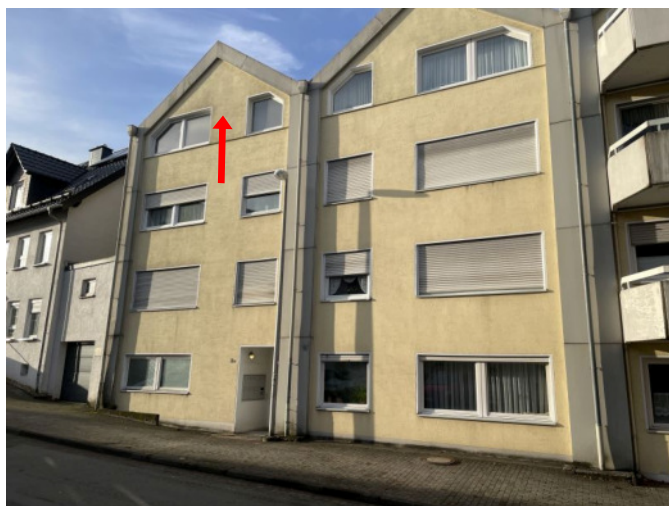
Mehrfamiliendoppelhaushälfte Gerichtstraße 2 a
