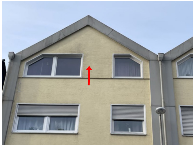
Wohnung Nr. 6 im Dachgeschoss links - Straßenansicht
