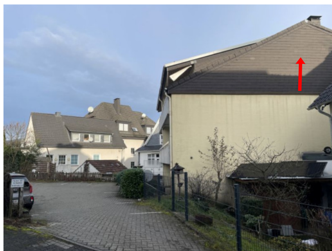
Südansicht Wohnung Nr. 6 im Dachgeschoss
