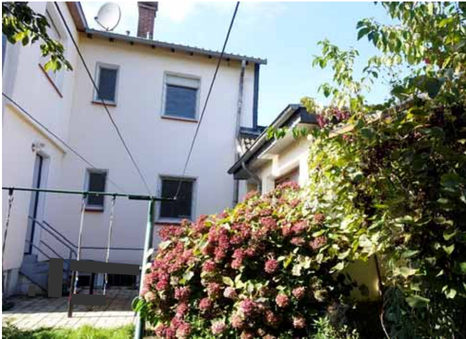
Rückansicht der Gebäude
