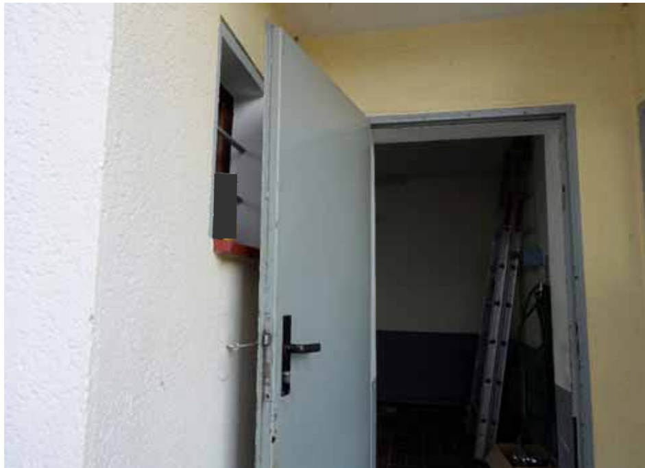
vom Garagenraum zum rückwärtigen Grundstücksbereich führende Tür
