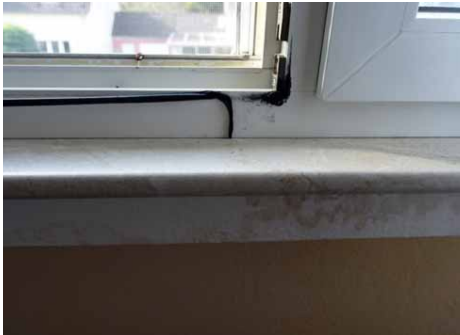
Feuchtigkeitsschäden und beschädigte Fensterdichtung im Zimmer I des Dachgeschosses
