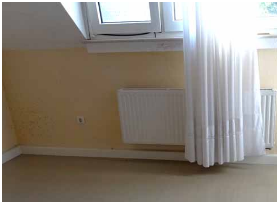
Feuchtigkeitsschäden und beschädigte Fensterdichtung im Zimmer I des Dachgeschosses
