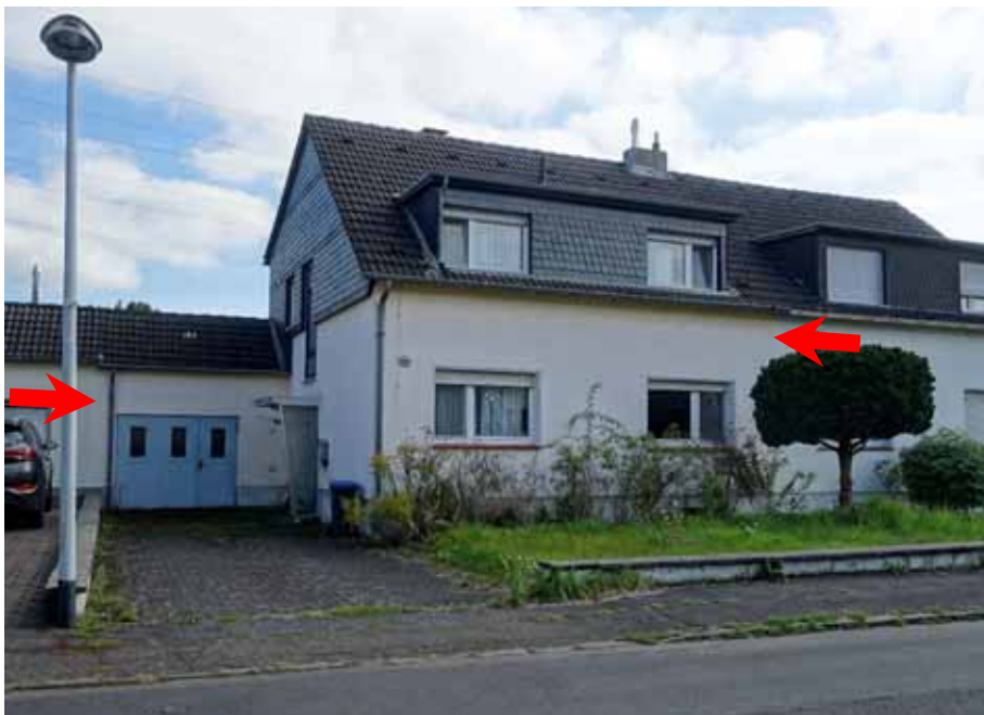
Straßen-/ Seitenansicht der Gebäude
