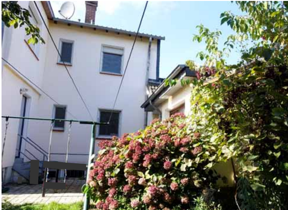
Rückansicht der Gebäude
