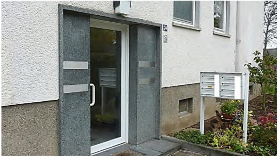
Hauseingangsbereich Am Hochfeld 34
