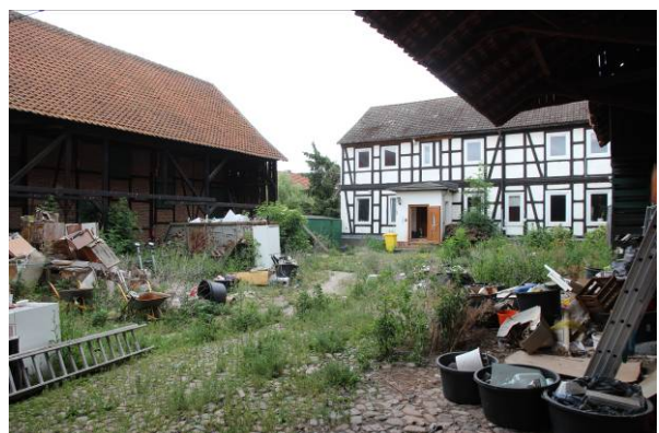
Hofbereich mit Wohnhaus
