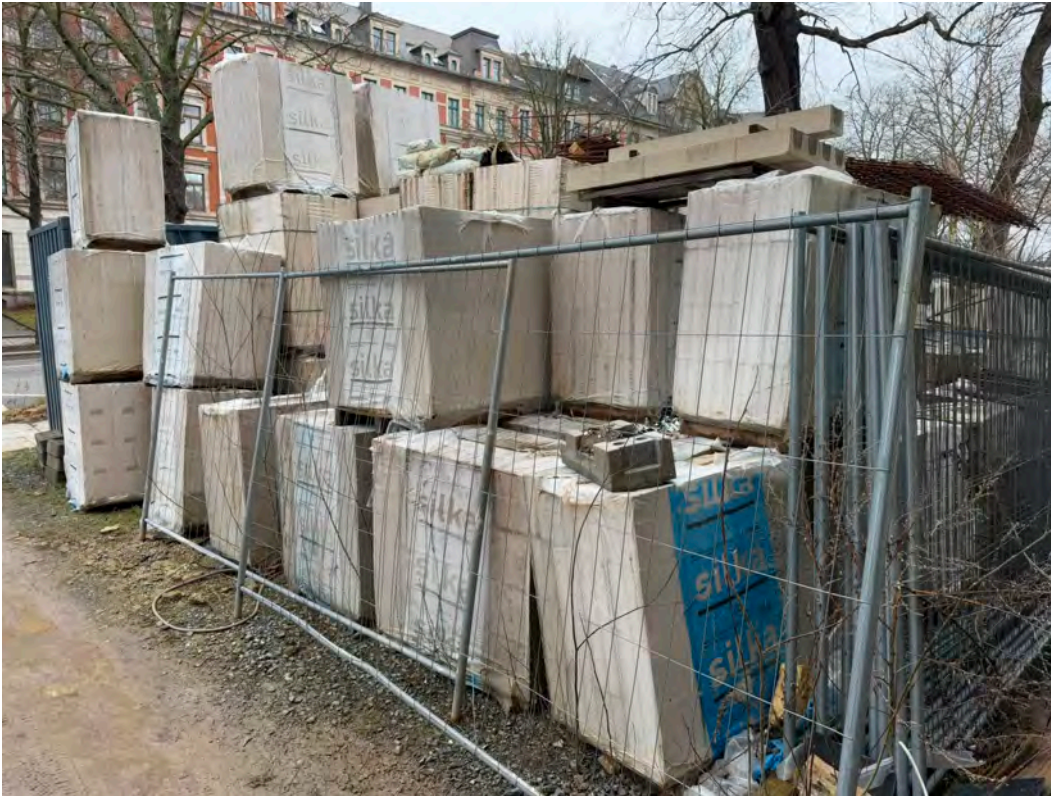
Paletten mit Kalksandsteinen (siehe Punkt 9)o
