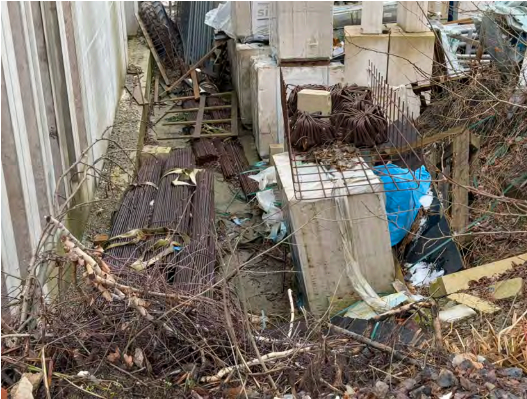
Betonstahl (Stäbe und Bügel; Menge nicht ermittelt), siehe Punkt 9
