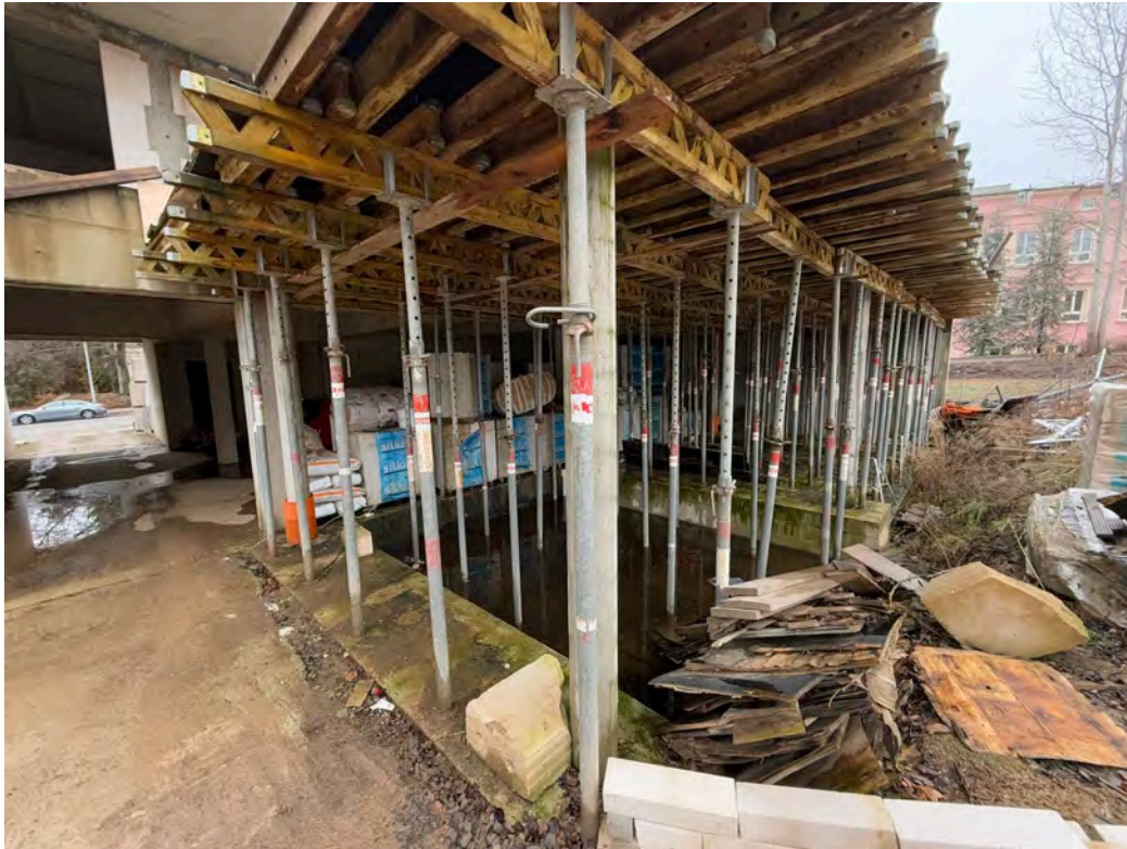
gartenseitiger Anbau, in welchem die Stellplätze geplant waren (Schalungstützen und Holzschalungsträger siehe Punkt 9)
