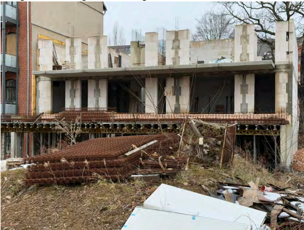
Rückseite des Rohbaus
