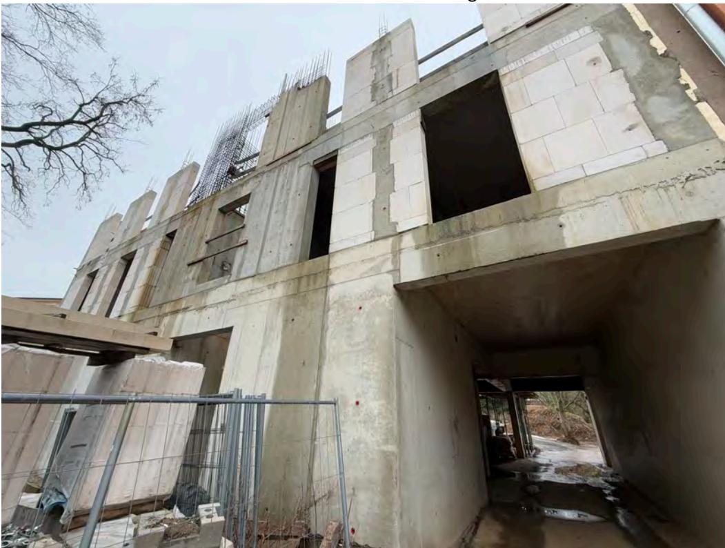
Straßenseite des Rohbaus
