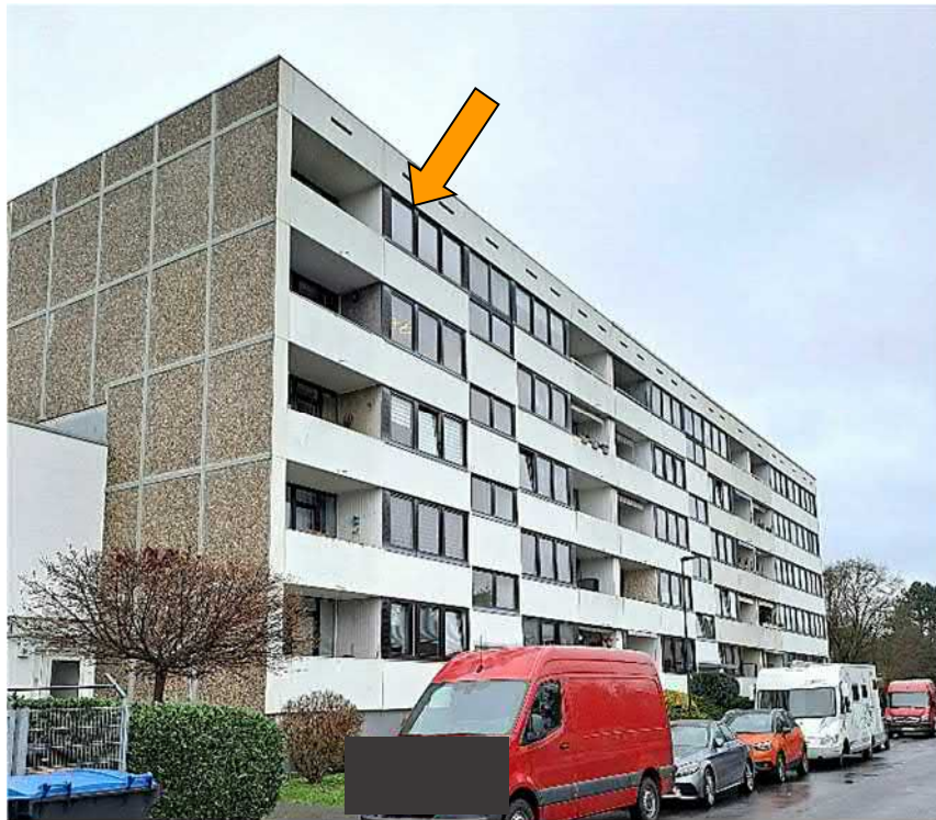
Straßenansicht von Westen
