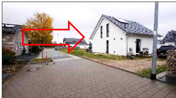
Bild 1: Blick in die Erschließungsstraße mit Bewertungsobjekt
