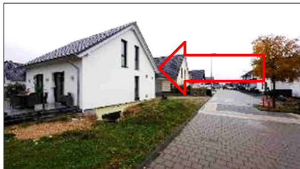
Bild 2: Blick in die Erschließungsstraße mit Bewertungsobjekt
