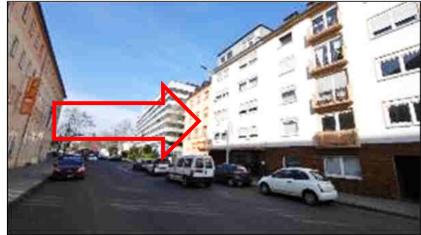
Bild 2: Blick in die Erschließungsstraße
