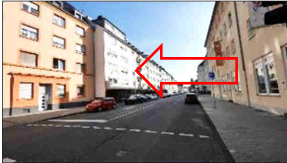
Bild 1: Blick in die Erschließungsstraße
