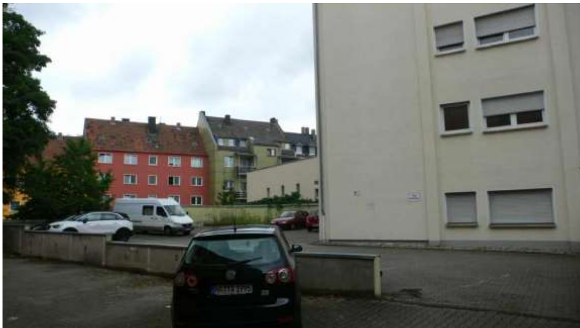
Bild 14: Zufahrt Hinterhof, Blick nach Norden
