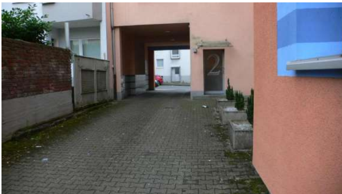
Bild 15: Zufahrt Hinterhof von der Boeler Straße
