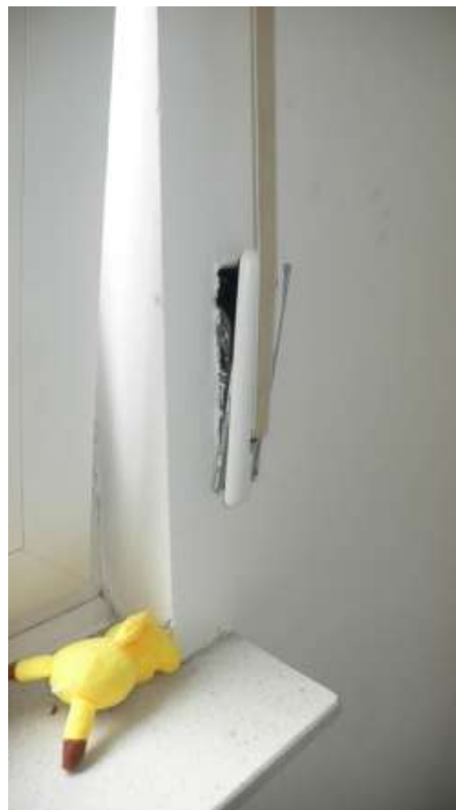
Bilder 59 + 60: Kinderzimmer mit defekter Sockelleiste und Rolladenkasten
