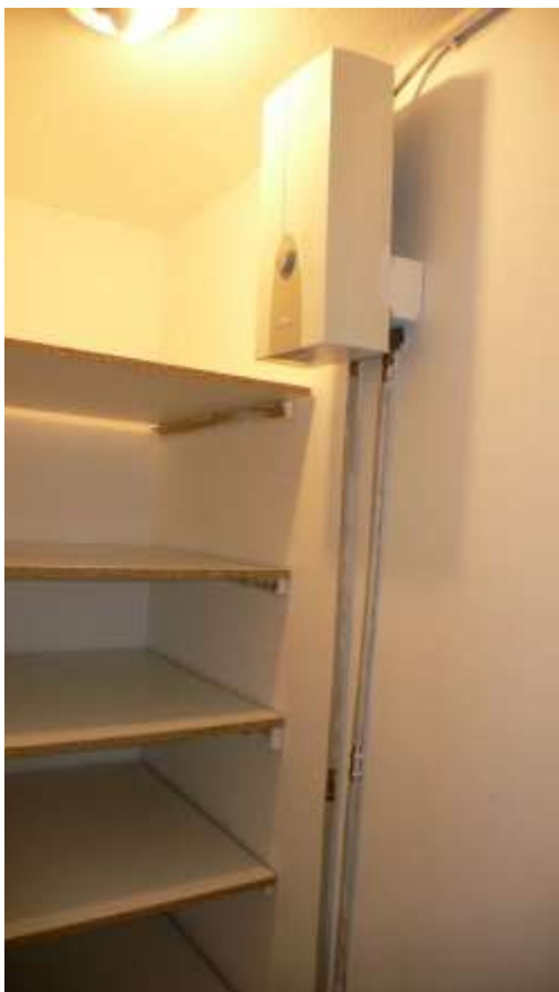
Bild 47 + 48: Abstellraum mit Elektrodurchlauferhitzer und Unterverteilung
