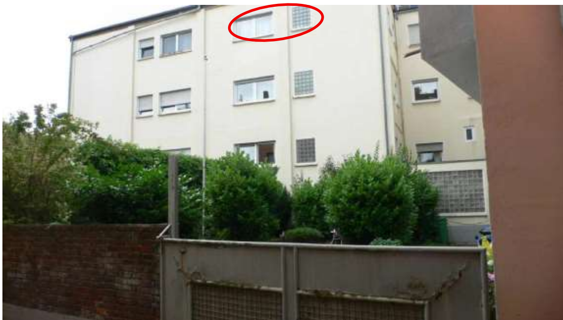
Bild 11: Hinterhof SW, Fenster der Wohnung Nr. 20 (rot)
