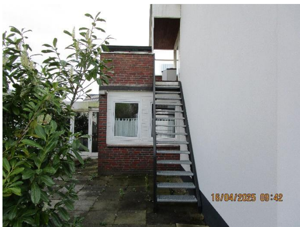
Außentreppe zum Obergeschoss
