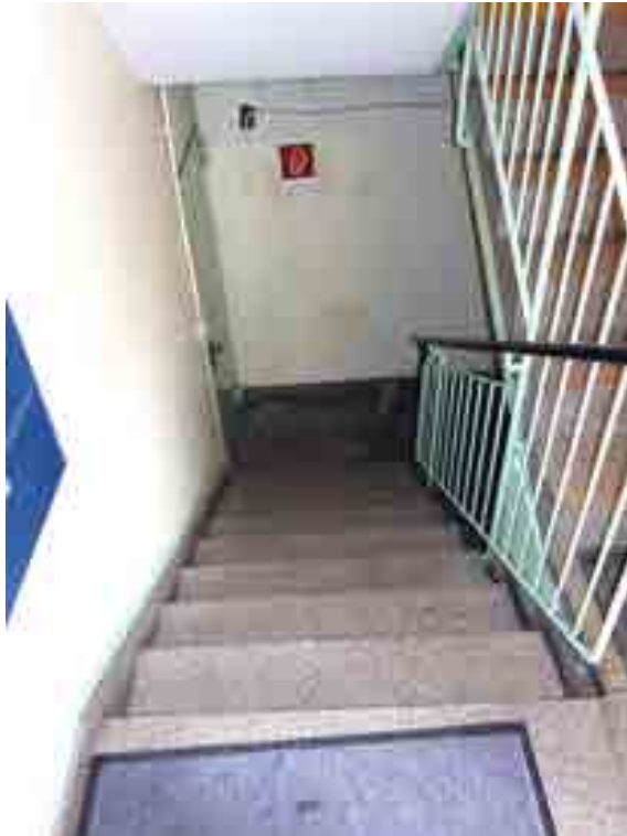
Treppe zum Kellergeschoss
