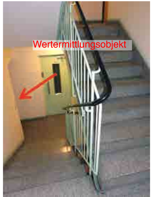
Treppenhaus; die Wohnungseingangstür ist markiert
