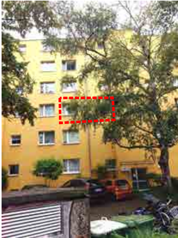
Ansicht von der Schinkestraße; die Lage der WE ist markiert
