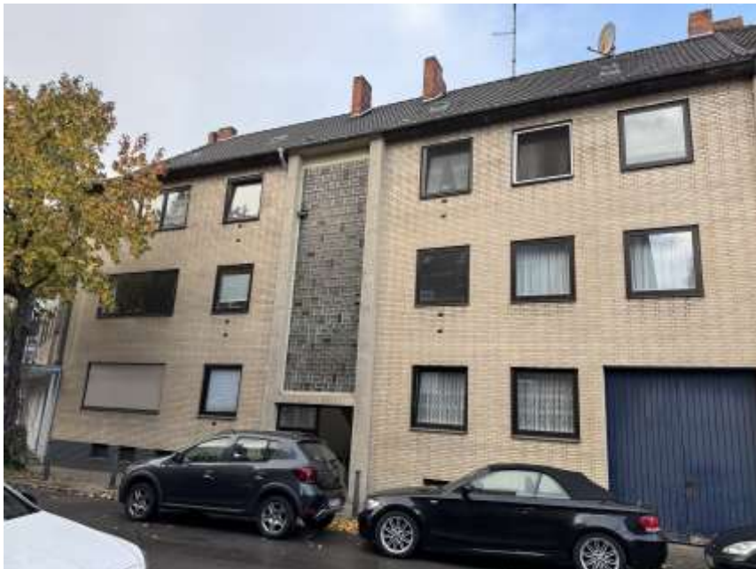
Bild 2: Hauseingang Laaker Str. 39
