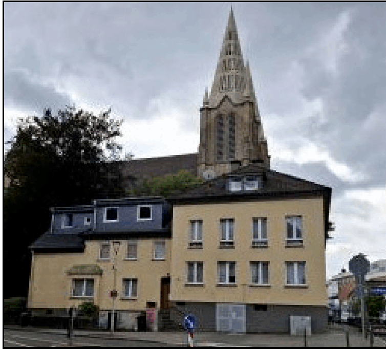
Foto 1: Ansicht von der Straße Unter St. Clemens
