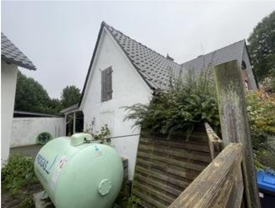
Westansicht des ehem. Stalls
