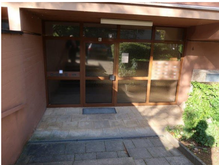
Bild 5 Hauseingang zu Haus Nr. 6
