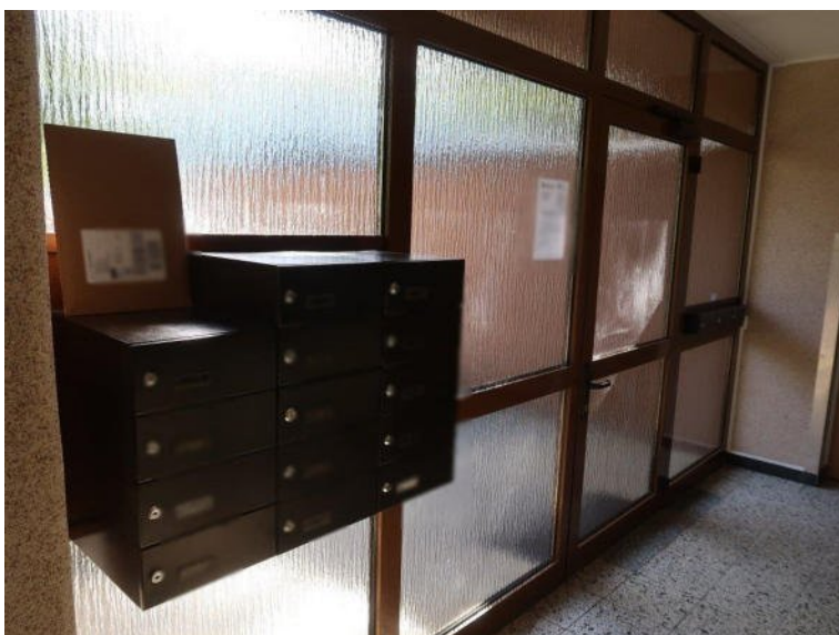
Bild 6 Innenansicht Eingangsbereich Haus Nr. 6 (Gemeinschaftseigentum)
