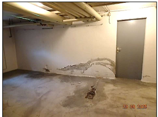
Feuchtigkeitsschaden KG
