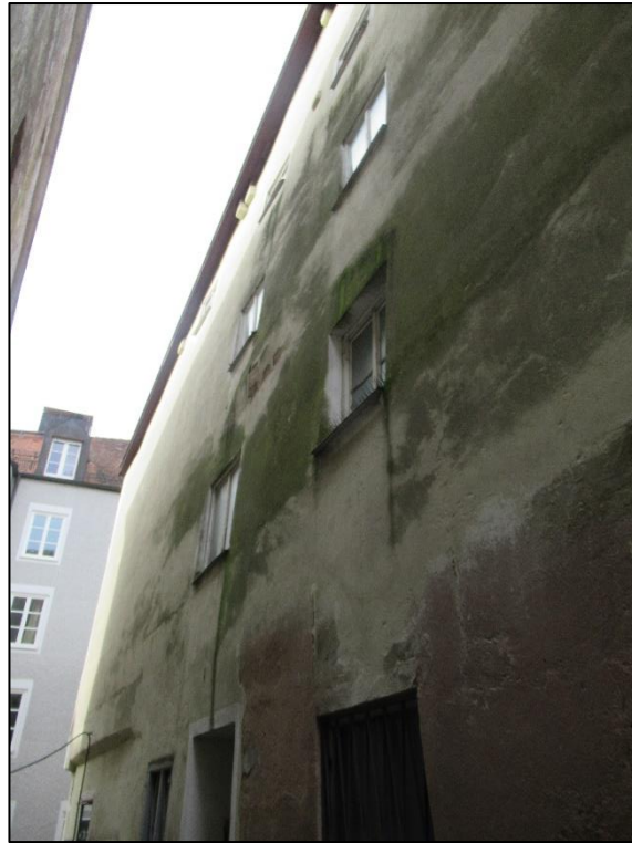
Feuchteschaden, Putz-/Farbabplatzungen
