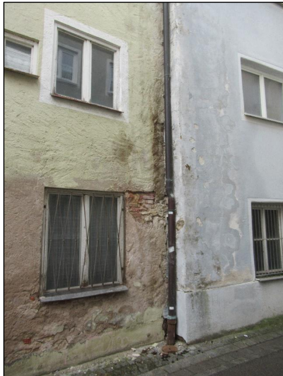
Feuchteschaden, Putz-/Farbabplatzungen
