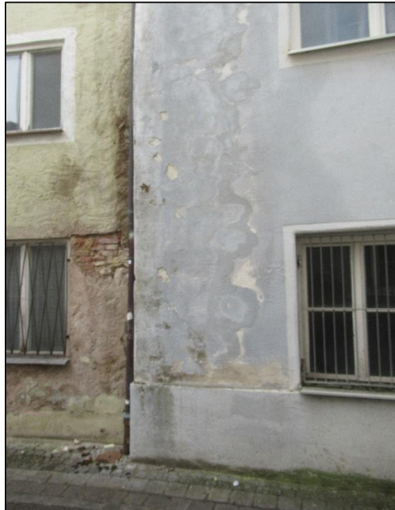
Feuchteschäden, Putz-/Farbabplatzungen
