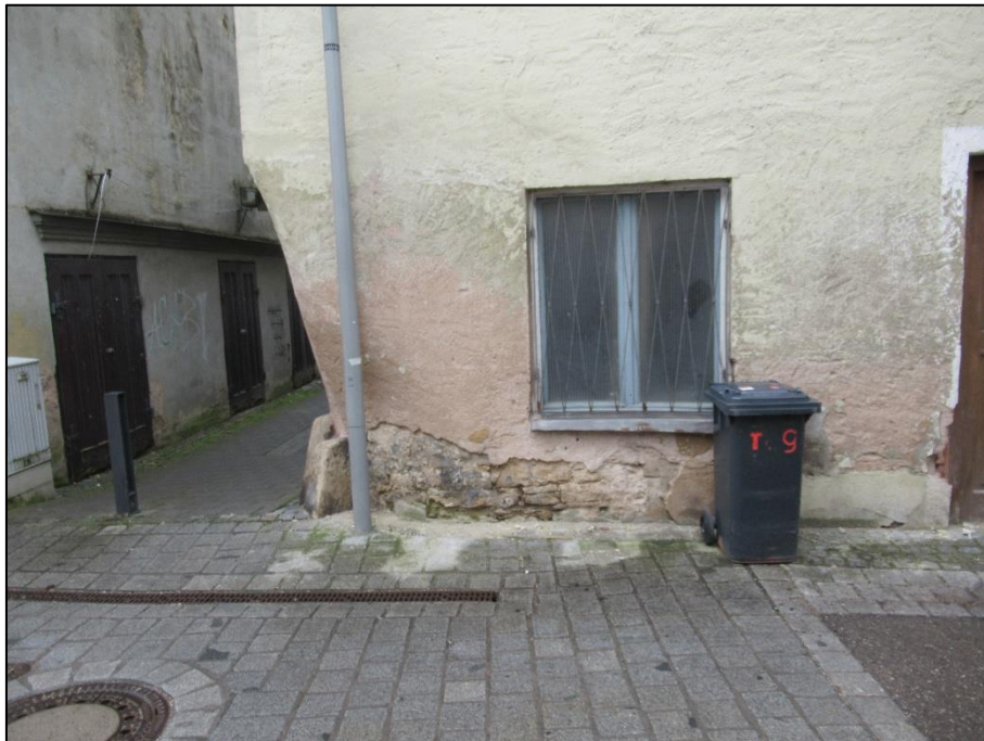
Feuchteschaden, Putz-/Farbabplatzungen
