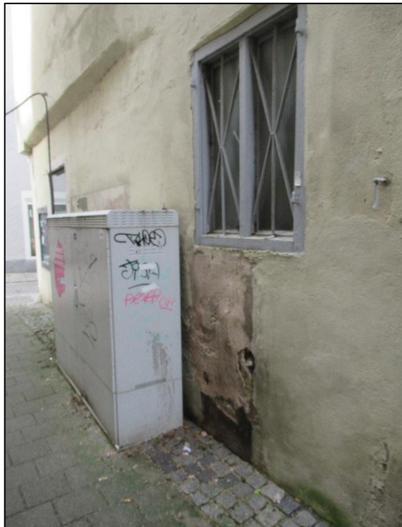
Feuchteschaden, Putz-/Farbabplatzungen
