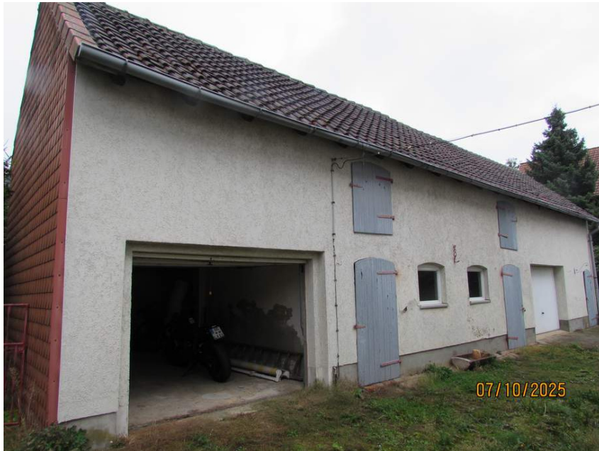
Abbildung 7: Blick auf das hofseitige Nebengebäude.
