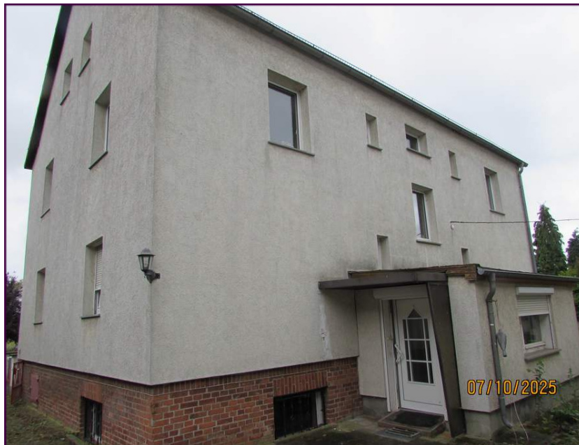
Abbildung 2: Blick vom Innenhof mit Hauszugang.
