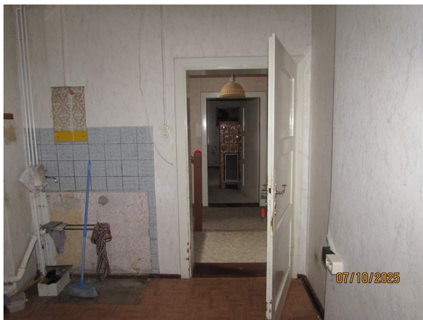
Abbildung 4: Teilansicht der Wohnräume im EG.
