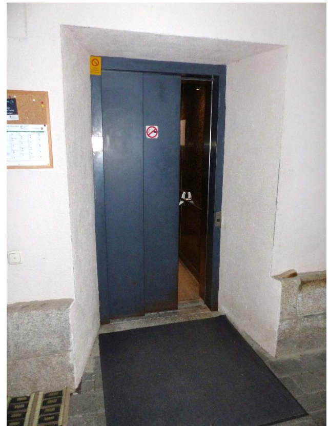
Fahrstuhl-Zugang im Erdgeschoss
