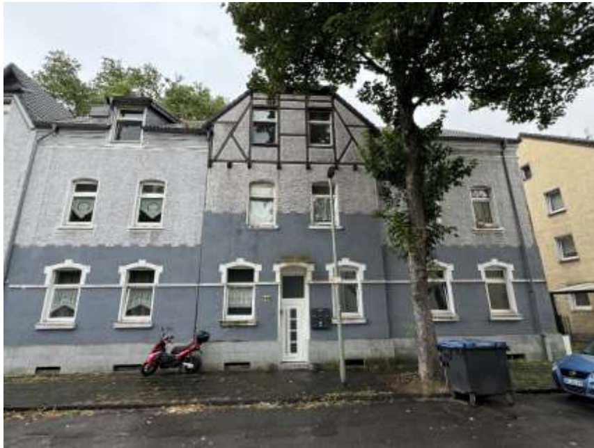
Bild 3: Straßenansicht Haus Seydlitzstr. 54
